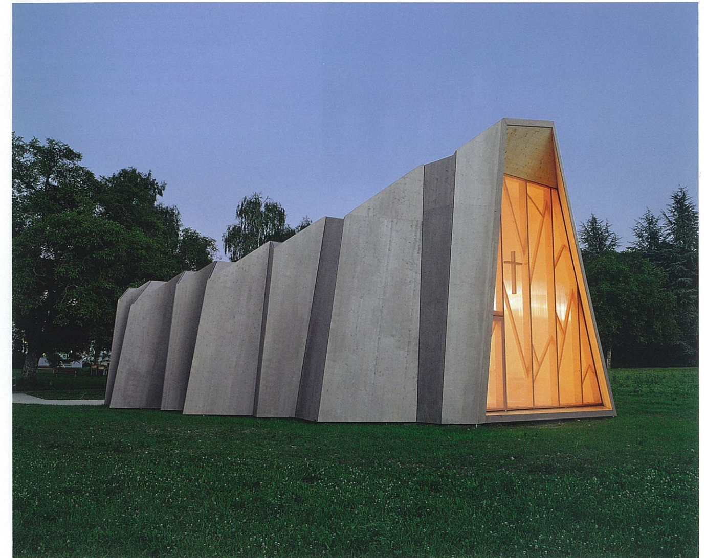
Die Tragstruktur der Kapelle Saint-Loup in Pompaples definiert gleichzeitig den Raum. Planer: Localarchitecture Sàrl, Lausanne, und Bureau d'architecture Danilo Mondada, Lausanne, mit Shel, Architecture, Engineering and Production Design, Hani Buri und Yves Weinand, Genf
